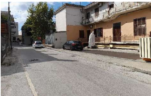
c. Via Scotellaro (marciapiede)
