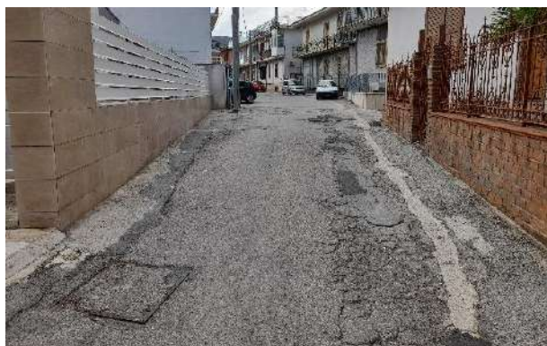
a. Via Malta (pavimentazione)
