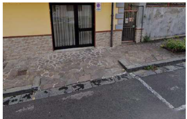
b. Via Libertà (marciapiede con rampa)
