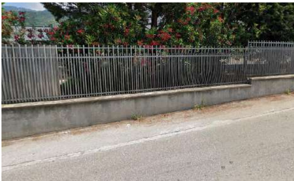
c. Via Malta (assenza marciapiedi)
