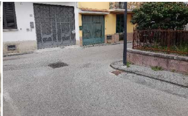
b. Via Foscolo (primo tratto, pavimentazione)
