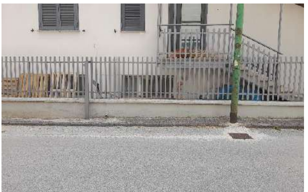
d. Via Scotellaro (passaggio ostruito)
