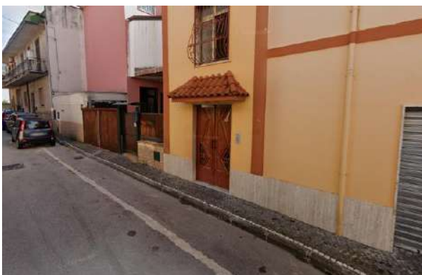
c. Via Viviani (marciapiede)
