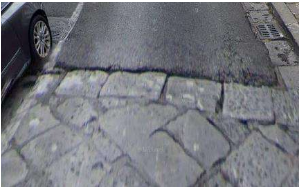
a. Via Libertà (cambio pavimentazione)
