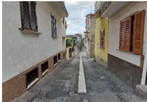
d. Via Gesù e Maria (pavimentazione primo tratto)
