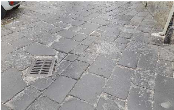
c. Via Malta (pavimentazione)
