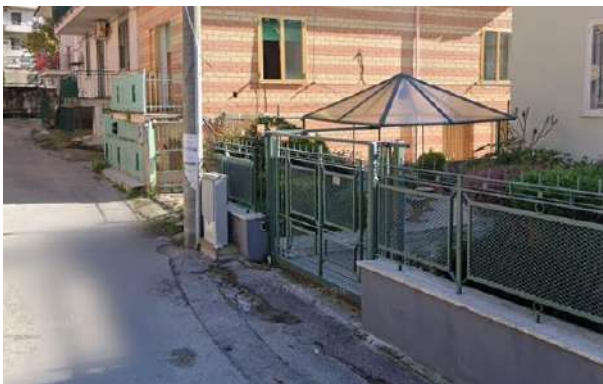
c. Via Candela (passaggio ostruito)
