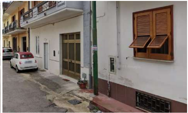
b. Via La Malfa (passaggio ostruito)
