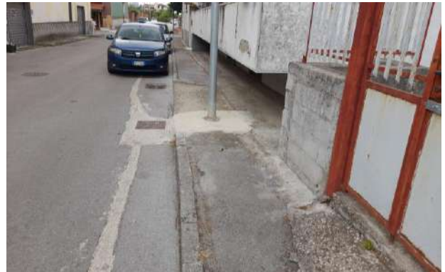
b. Via Moro (passaggio ostruito)
