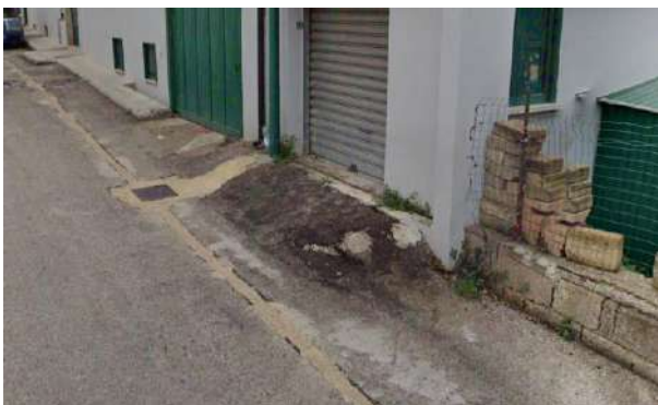
c. Via La Malfa (pavimentazione)
