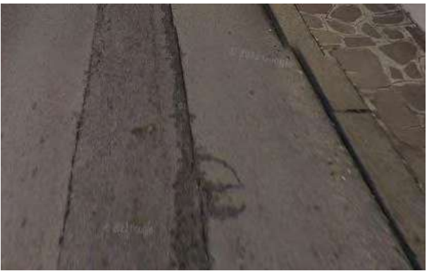
d. Via Diaz (pavimentazione)
