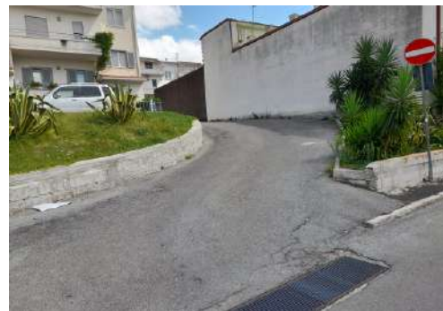
b. Via Gramsci (passaggio ostruito)
