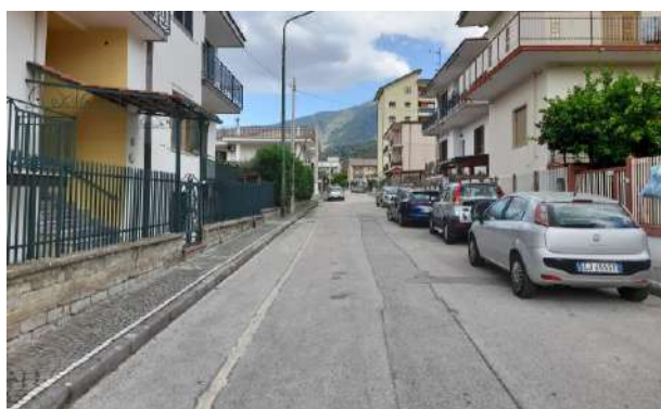
c. Via Togliatti (passaggio ostruito)
